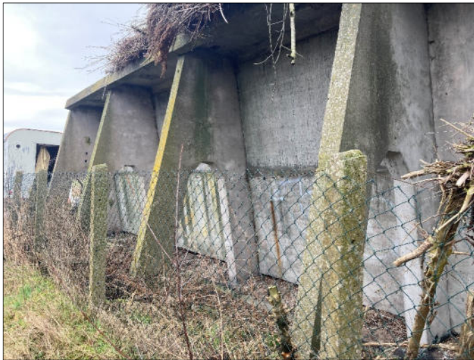
Abb. 20: Nachfolgende Abbildungen zeigen den Zustand der geplanten Kompensationsflächen 02/2022. (Aufnahmen Hagen Roßmann)
