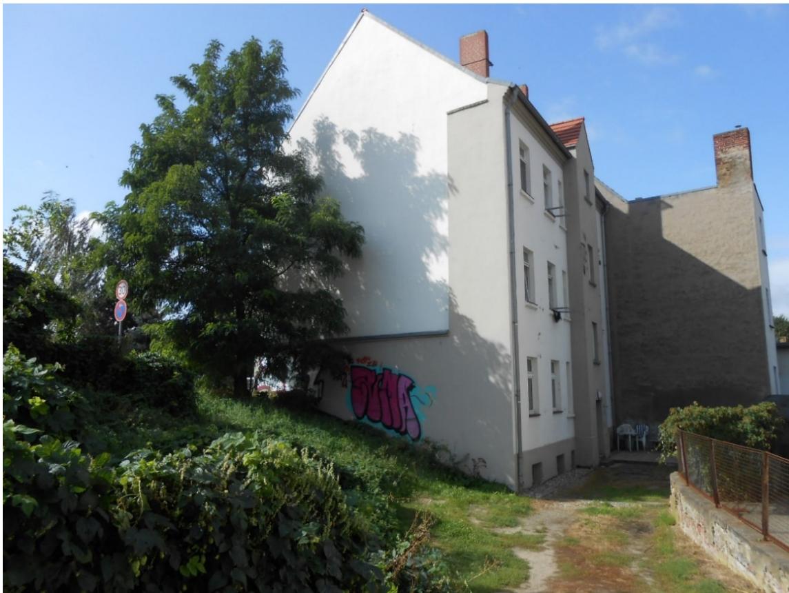
Grundstück mit Einfahrt von der Straße Beetzseeufer aus gesehen. Die Robinie wurde inzwischen gefällt. Im Hintergrund das Nachbargrundstück mit dem Haus Mühlentorstraße 21
