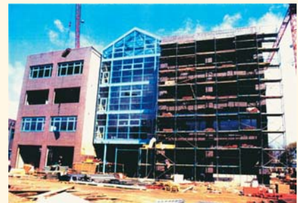
In der Rohbauphase
