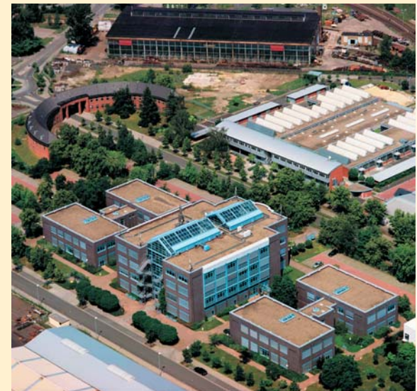
Das TGZ in Betrieb
