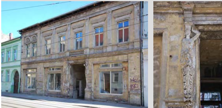
Zustand vor der Sanierung
