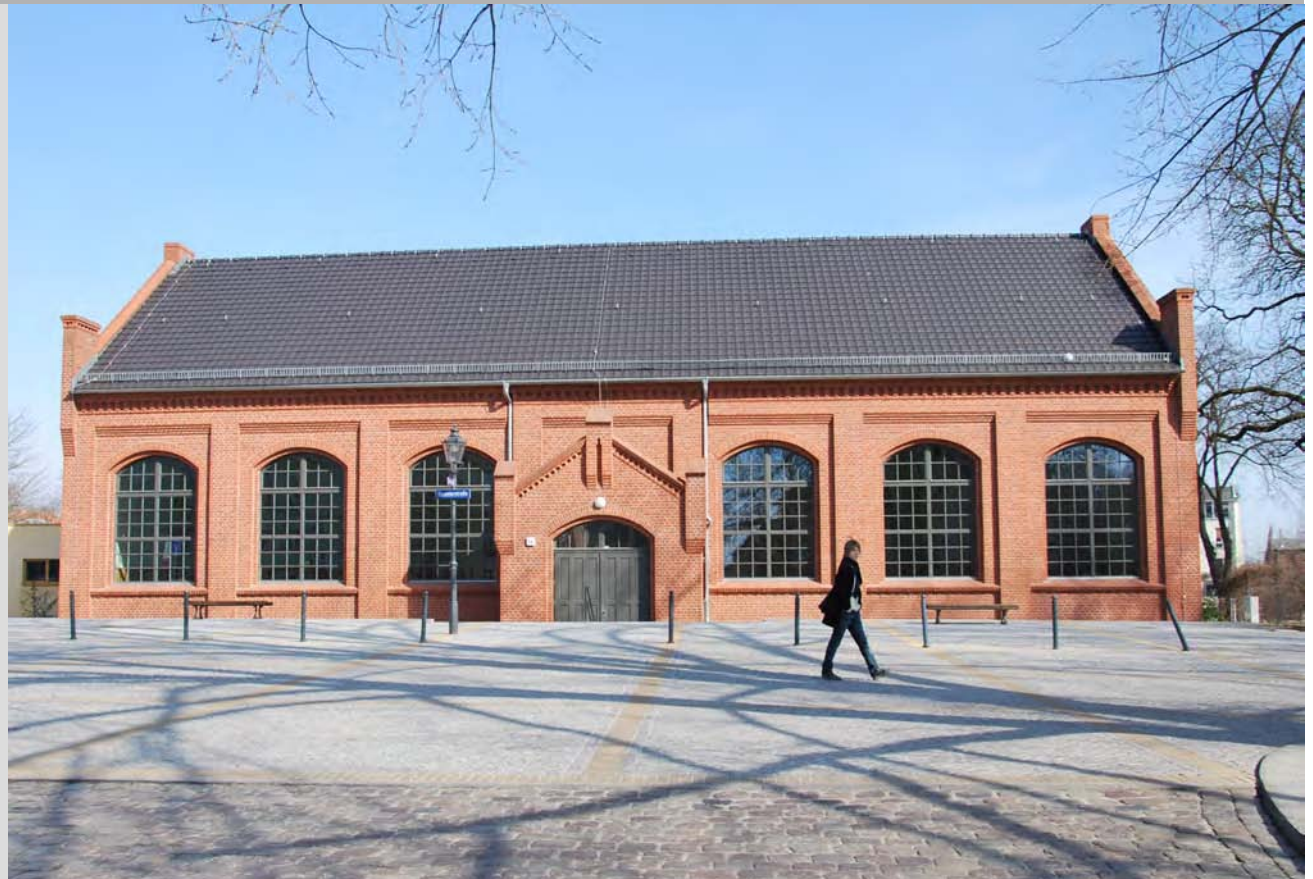
2005 Sanierung und Erweiterung
