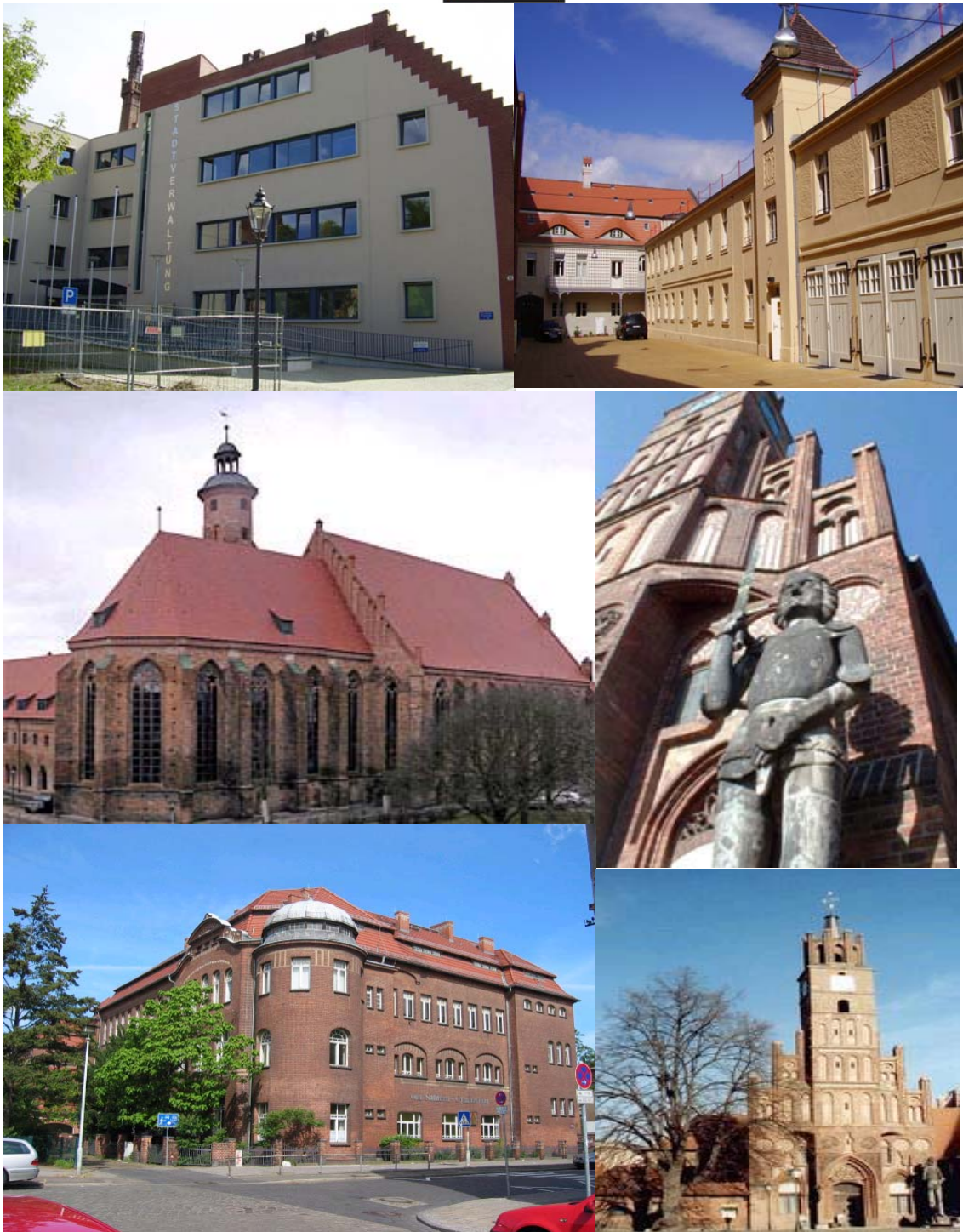
Fotos: Zentrales Gebäude- und Liegenschaftsmanagement
