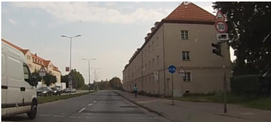
Foto: Abschnitt mit schadhaften Beton in der Fahrbahn und Beschränkung der Geschwindigkeit aus Lärm- schutzgründen auf 30 km/h (nur Lkw)
