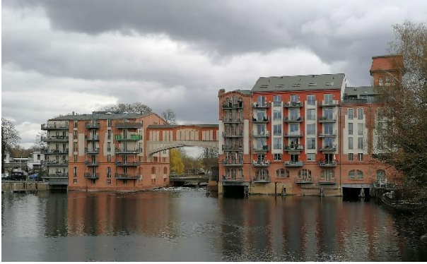
Abbildung 1: Mittel- und Burgmühle (Foto privat)
