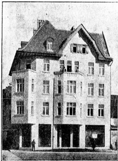
Geschäfts- und Wohnhaus in Guben i. L. (Ganz in Eisenbeton ausgeführt 1908.) Fertiger Bau.
