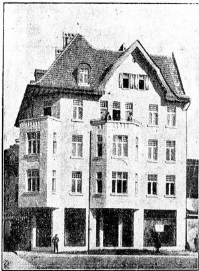
Geschäfts- und Wohnhaus in Guben i. L. (Ganz in Eisenbeton ausgeführt 1908.) Fertiger Bau.
